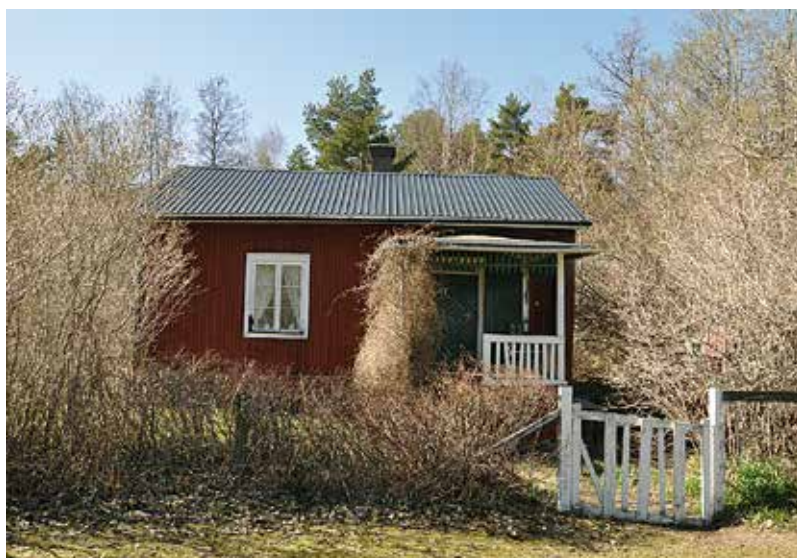
Ahlstrands torp ligger vid stranden ovanför den norra piren söder om fästningsruinen. Huset är byggt på en gammal magasinsgrund och fanns redan 1885. Foto: förf. 2011.
